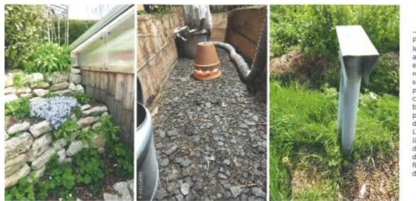
Par temps froid, le puits canadien aspine l'air extérieur et le rejette. réchauffé, dans la serre (à droite). Des pots en terre cuite chauffés par des bougies chauffe-plat permettent aussi de gagner 2 à 3 °C. L'accès à la serre là garuchel, protégé du vent, héberge des fraises et des fleurs, notamment des aubriètes.
